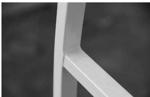
Фото 1. Сварка элемента торца
