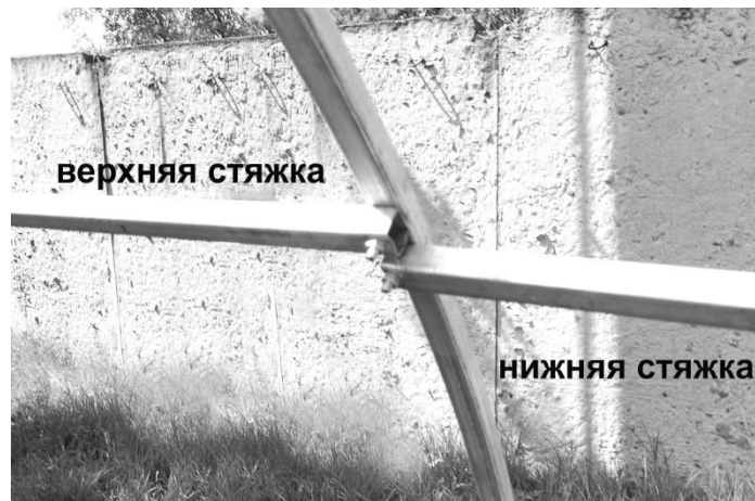
Фото №4. Стяжки в шахматном порядке.
